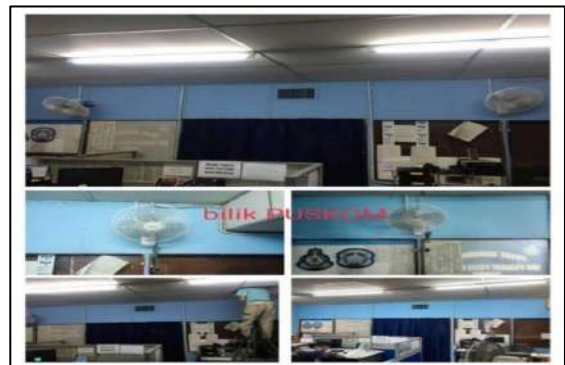
IPD Tawau, Sabah - Baki 7 Unit Kipas Dinding Yang Telah Dipasang Selepas Lawatan Audit (Berdasarkan Maklum Balas 12.04.2021)
