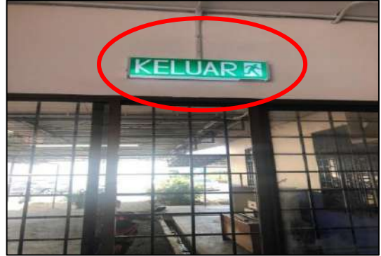
Pejabat Narkotik, IPD Padang Besar, Perlis - Lampu Tanda Atau Kecemasan (Tanpa Suis) Yang Dipasang (15.03.2021)
