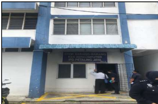
Kompleks Perumahan IPD Petaling Jaya Selangor - Unit Kuarters Digunakan Sebagai Stor Barang Kes Jenayah (02.09.2021)
