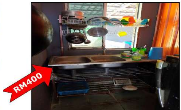
Bangunan Pejabat SJR Chuping AKSEM, Perlis - Sinki (RM400/unit) Yang Dipasang (18.03.2021)
