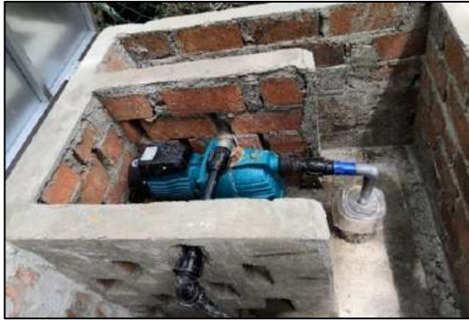
Balai Polis Wallace Bay, Tawau, Sabah - Rumah Pam Konkrit Dibina Tidak Mengikut Spesifikasi (08.04.2021)
