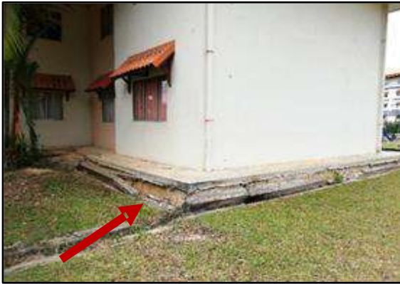
Mendapan Tanah Di Kwarters Yang Masih Diduduki Lokasi: Batalion 16 PGA Kota Kinabalu, Sabah Tarikh: 29.10.2019
