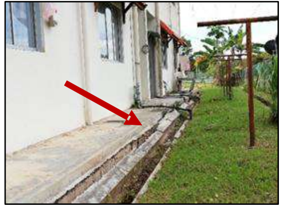
Mendapan Tanah Di Kwarters Yang Masih Diduduki Lokasi: Batalion 16 PGA Kota Kinabalu, Sabah Tarikh: 29.10.2019
