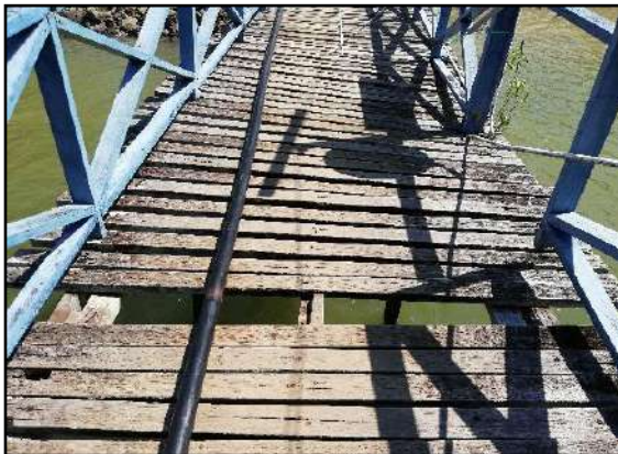
Titi Perhubungan Jeti Yang Rosak Lokasi: Pos Wallace Bay Tawau, Sabah Tarikh: 20.11.2019
